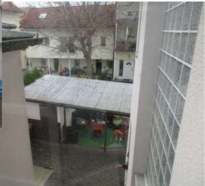
Überdachung/Carport in der Zufahrt vom Übergang aus
