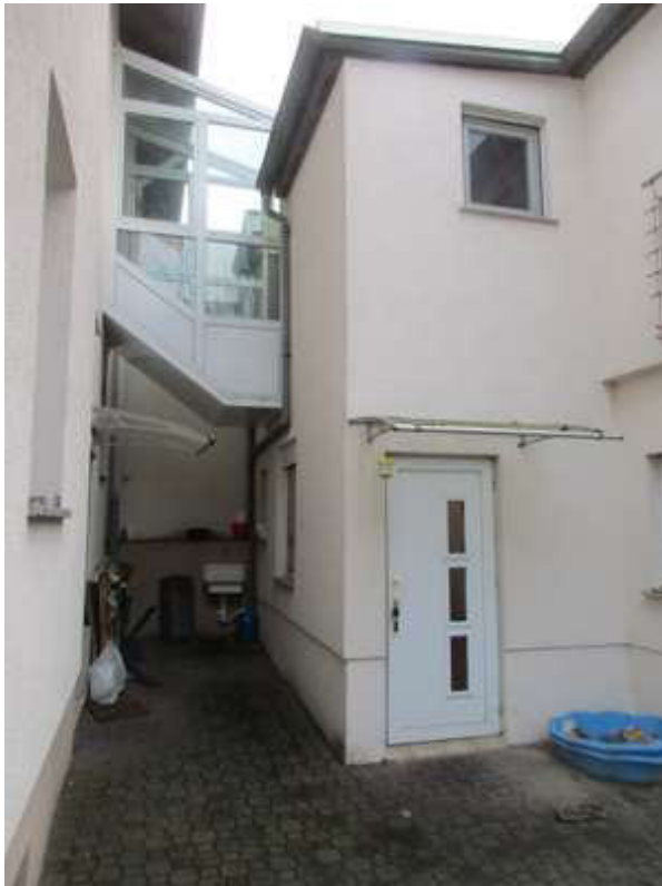
Vorderhaus und Hinterhaus von der Zufahrt aus - Verbindung im OG
