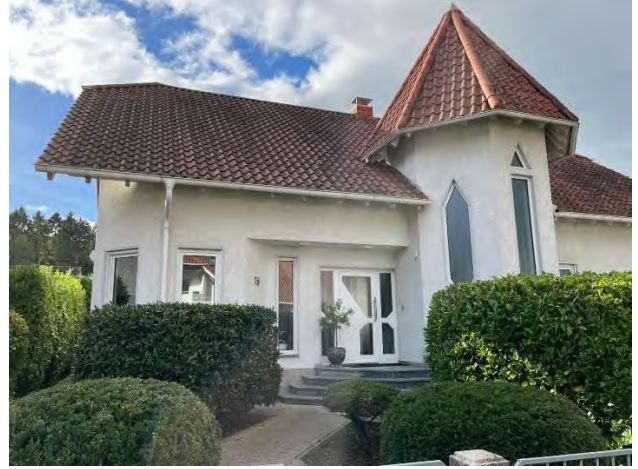
03 – Nordostseite mit Eingangsbereich
