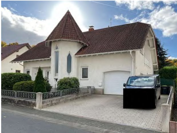
04 – Nordostseite mit Garageneinfahrt
