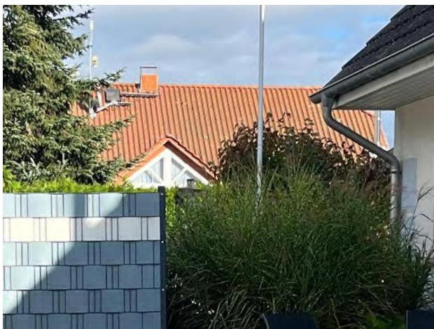
06 – Dach Gartenseite von Südwesten
