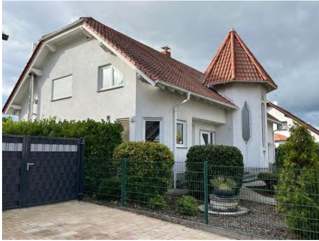
02 – Straßenansicht von Osten
