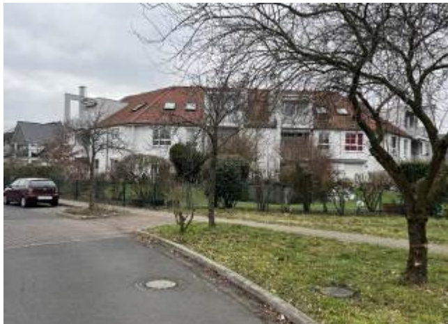
Straßenansicht – Lage der Wohnung Nr. 4 im Erdgeschoss
