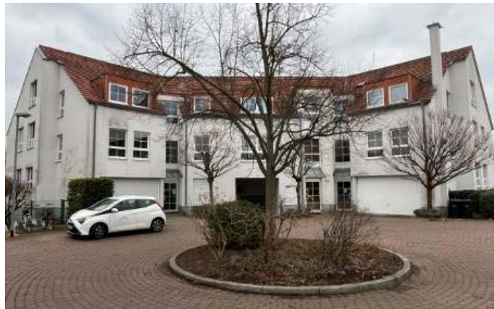
Ansicht Eingangsseite / Stichstraße, Wendehammer
