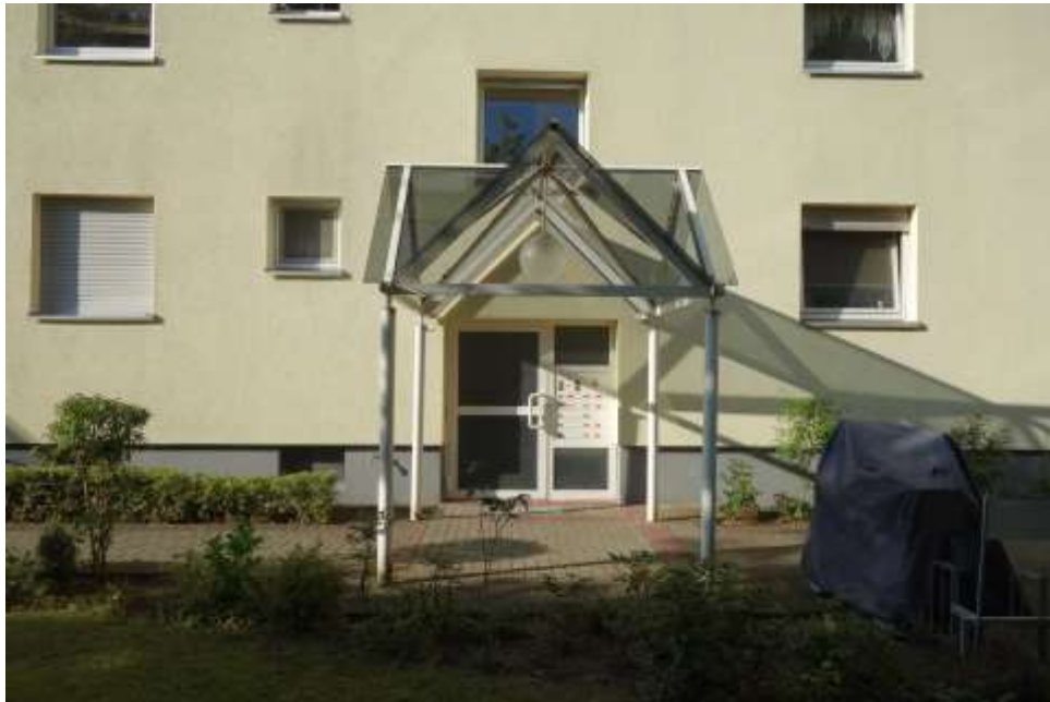
Bild 3: Ansicht des Hauseingangsbereichs
