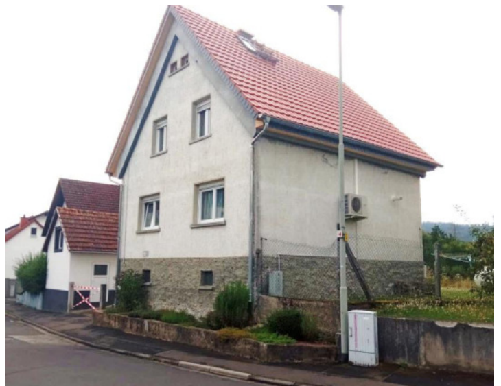
07 – Straßenansicht von Osten
