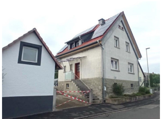
05 – Straßenansicht von Süden
