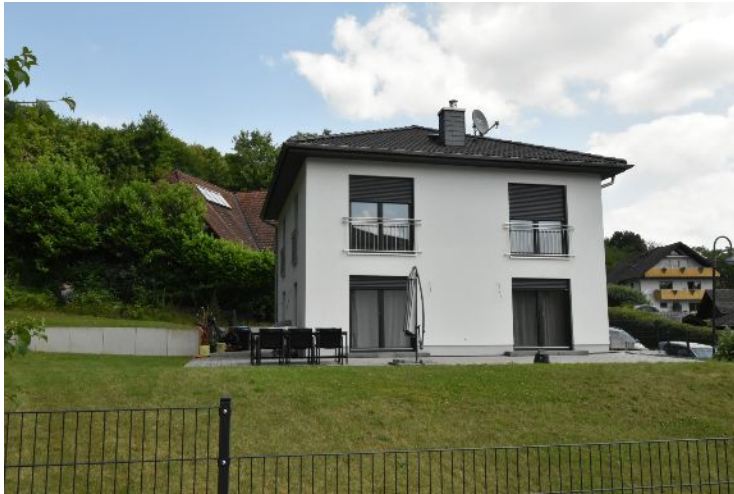
Bild 1: Ansicht von der Straße
