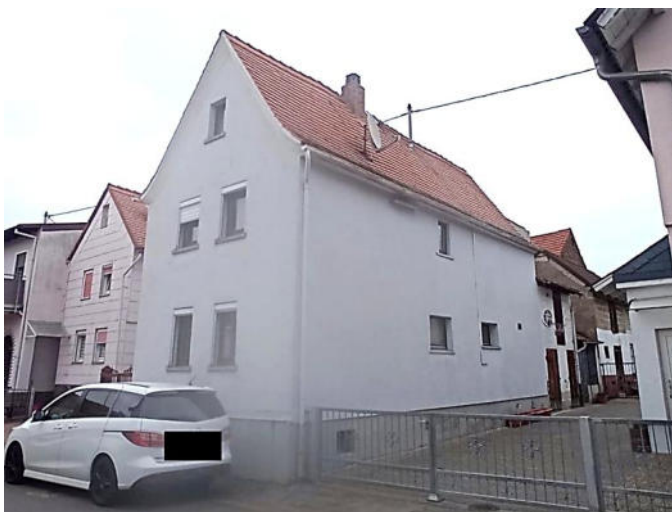
11 - Straßenansicht von Südwesten
