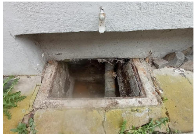
04 – Schacht vor Bad
