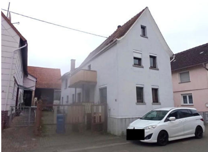
10 – Straßenansicht von Nordwesten
