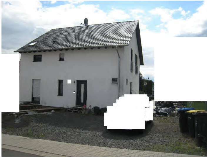
Bild Nr. 1, Straßenansicht
