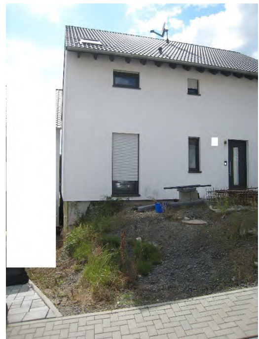
Bild Nr. 3, Ansicht zum Nachbargebäude.
