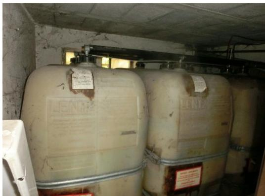
**Bild 28 – Öllager mit 3 Tanks a 1500 l**
