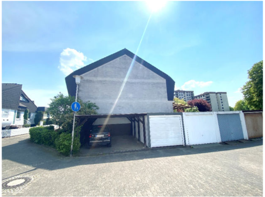
Foto 3 des SV: Stralsunder Straße; Haus-Nr. 1, Ansicht von Norden, mit Stellplätzen und Reihengaragen
