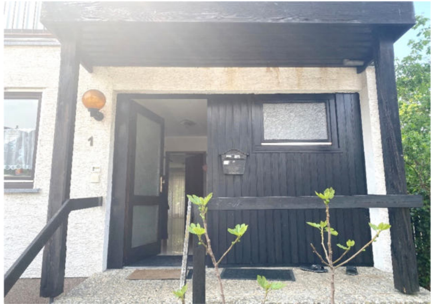
Foto 5 des SV: Hauseingang
