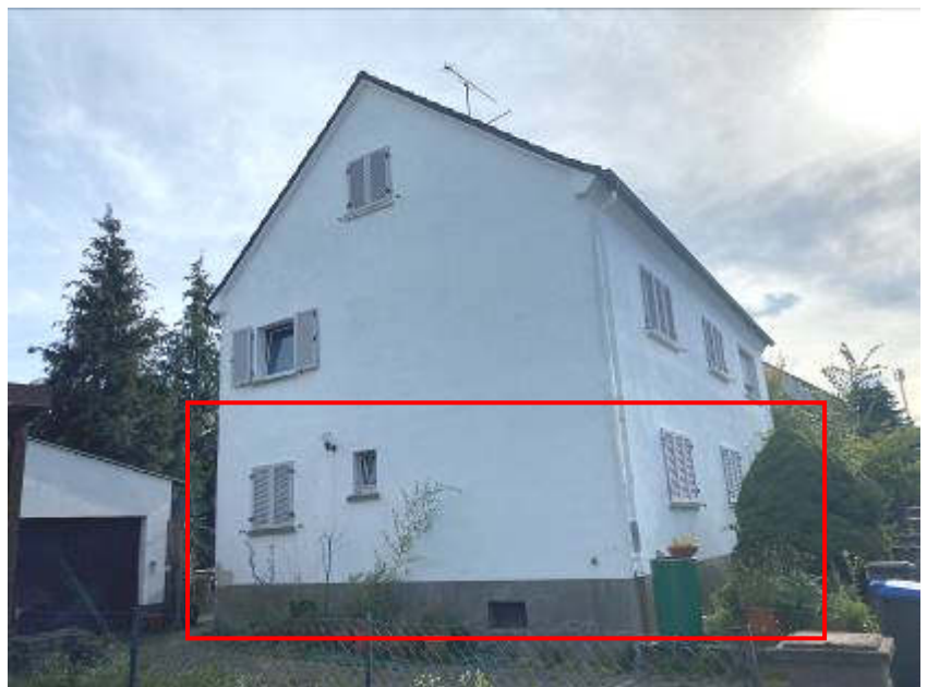
Foto 2 des SV: Ansicht von Norden, von der Straße Wiesenau, Detail: Wohnung/Sondereigentum Nr. 2; Rotmarkierung d.d. SV
