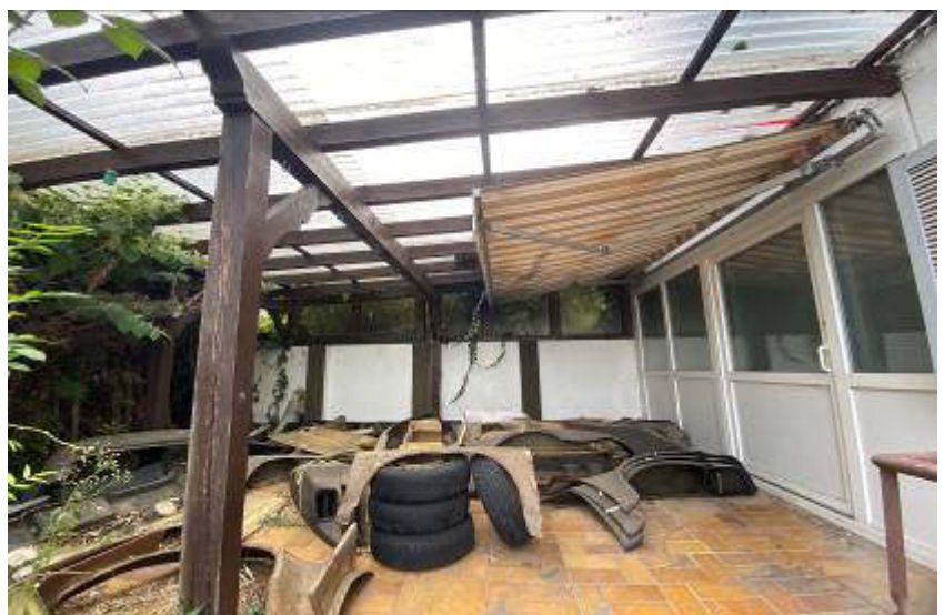
Foto 6 des SV: Terrasse; EG
