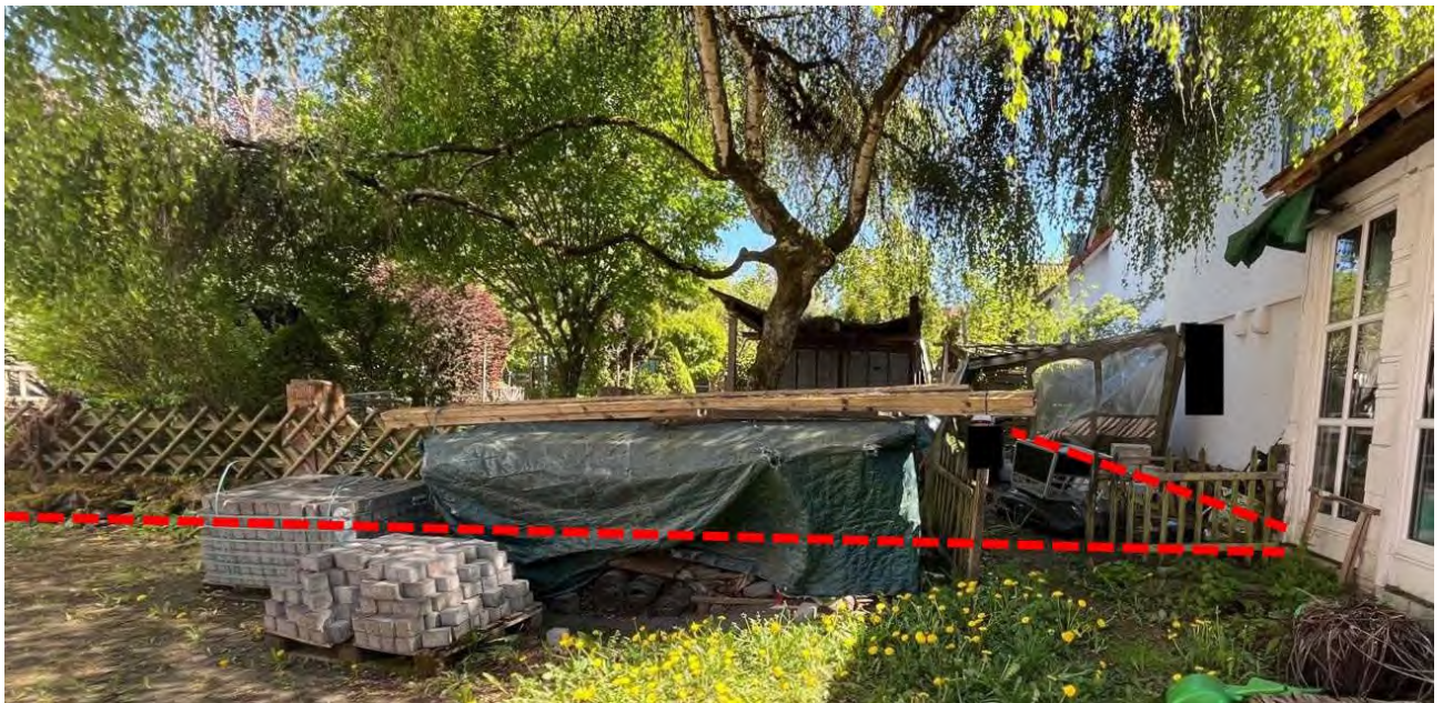
10 – Gesamtansicht von Nordwesten
