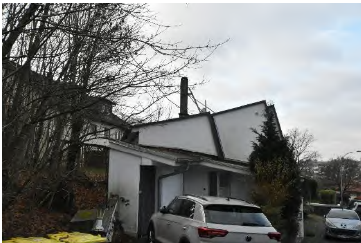
Bild 6: Treppenanbau mit Abstellraum
