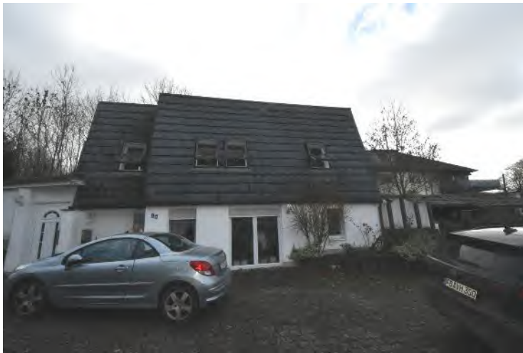
Bild 1: Ansicht von der Straße
