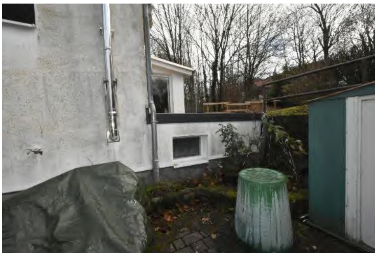
Bild 3: Rechte Giebelseite mit Dachterrasse
