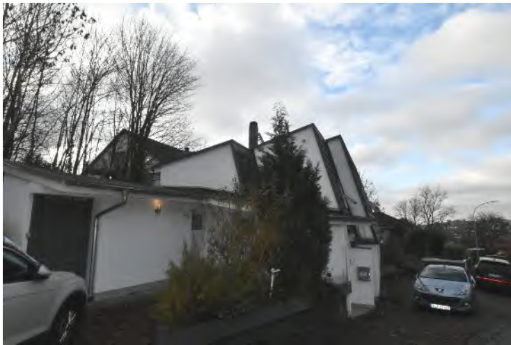
Bild 4: Im Vordergrund Treppenanbau
