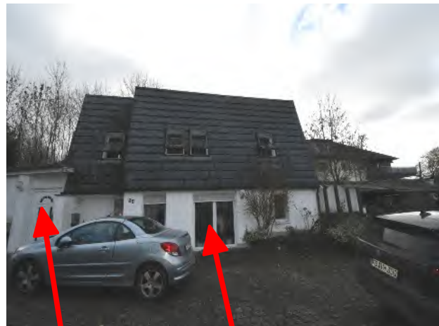
Treppenanbau und Wohnhaus
