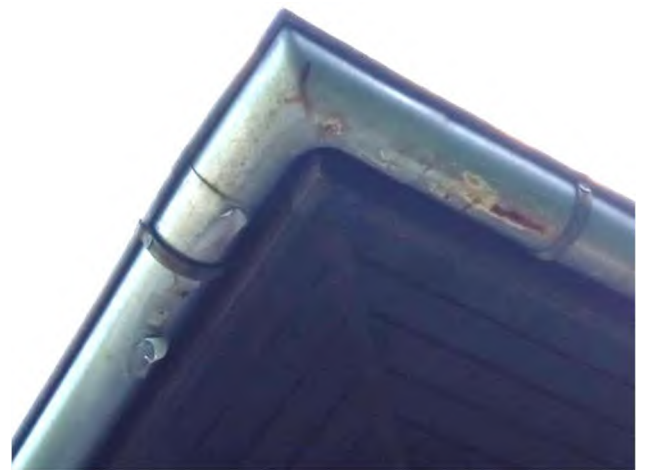
05 – Detail defekte Dachrinne
