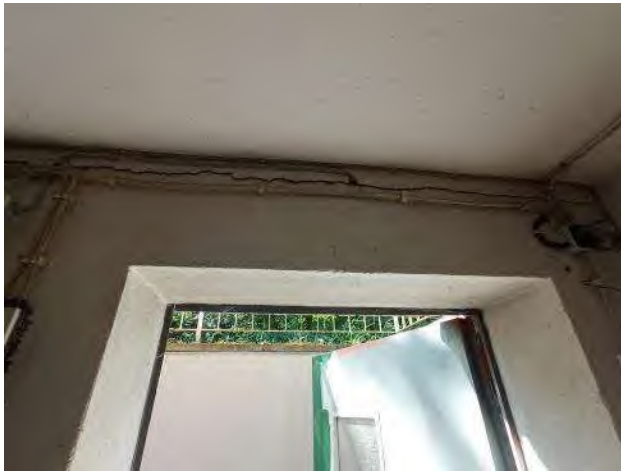
19 – Mauerwerksriss über Außentür
