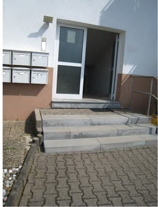
Bild Nr. 14, Eingangsbereich.
