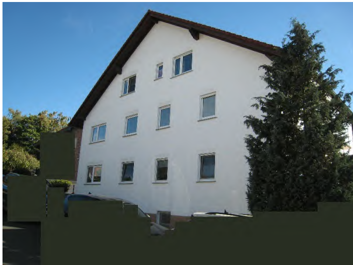
Bild Nr. 17, Ansicht nach Norden. Zur Straße.
