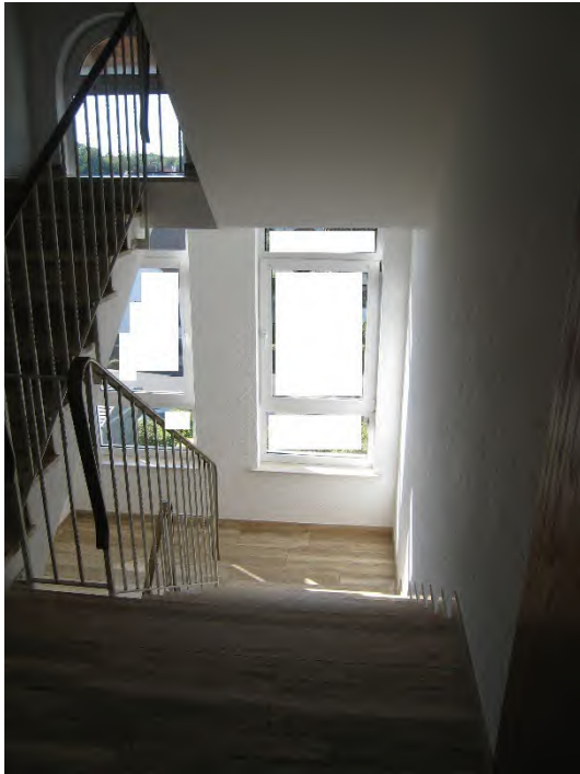
Bild Nr. 13, Treppenhaus in Richtung Hof.
