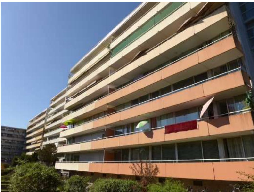
8 Hofansicht Haus Nr. 5 und 7
