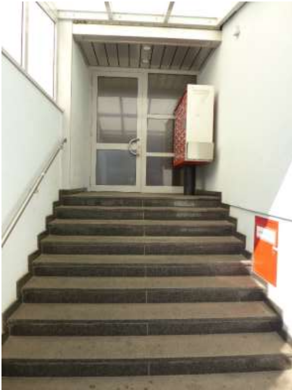
11a Eingangsbereich Haus Nr. 7-9
