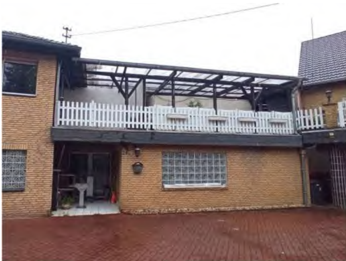
10 + 11 – Haus B von Süden mit Eingangsbereich
