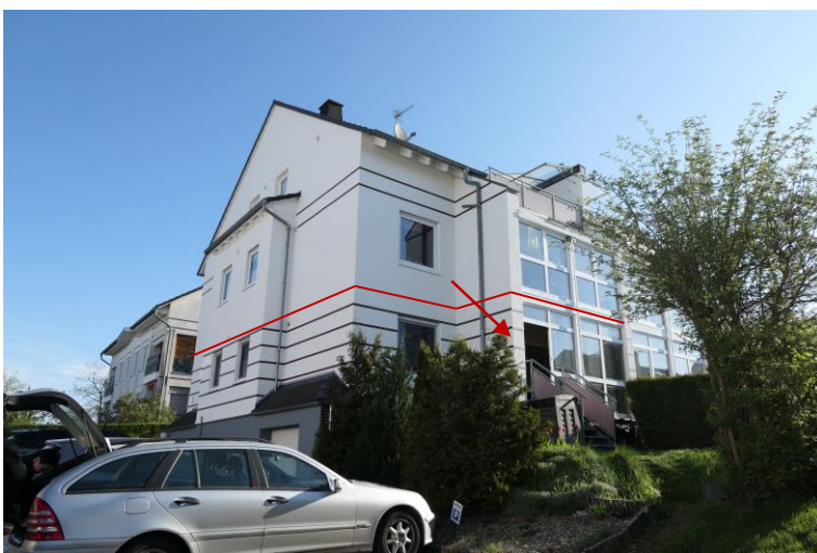
Bild 3 | Ansicht von Südwesten
