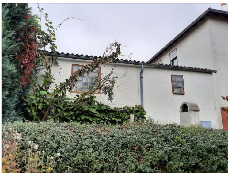
Abb. 4: Flurstück 65/1 mit Garagen, Rückansicht Garagen
