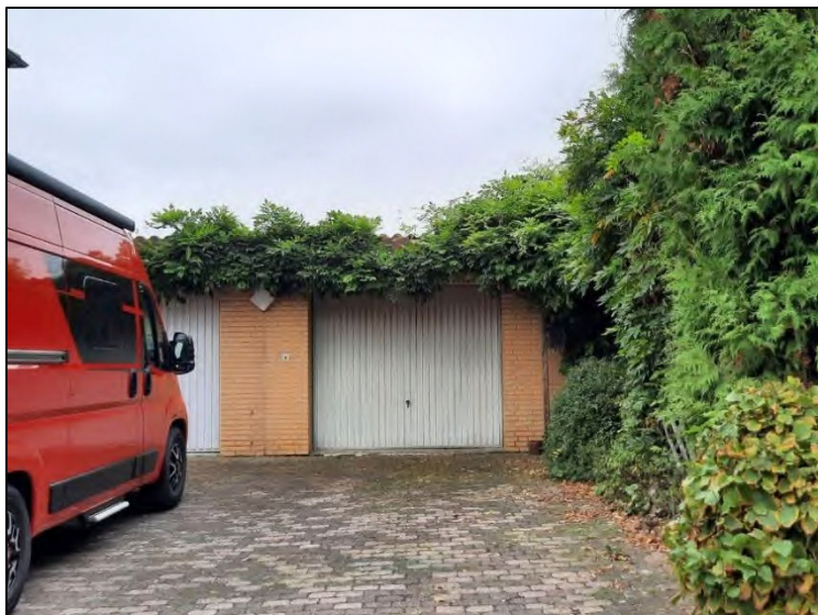
Abb. 3: Flurstück 65/1 mit Garagen, Zufahrt - Stellplatzmöglichkeit
