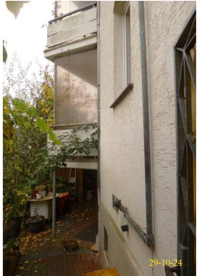
Ansicht Balkone von Osten
