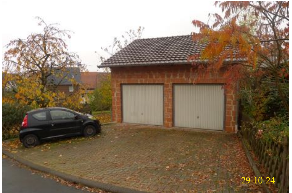
Doppelgarage Straßenansicht von Osten
