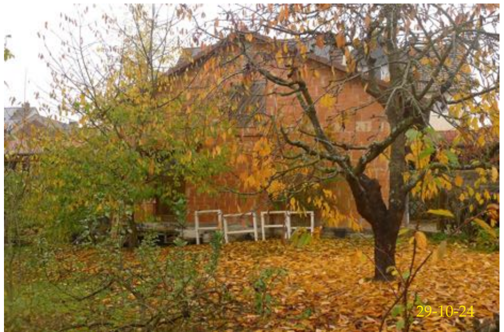
Doppelgarage Giebelwand von Süden
