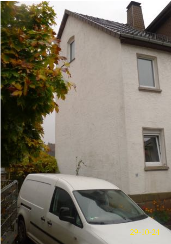
Giebelwand von Nord-Osten
