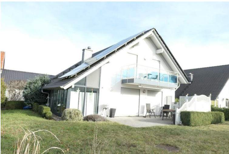
Bild 2 | A Ansicht von Südwesten
