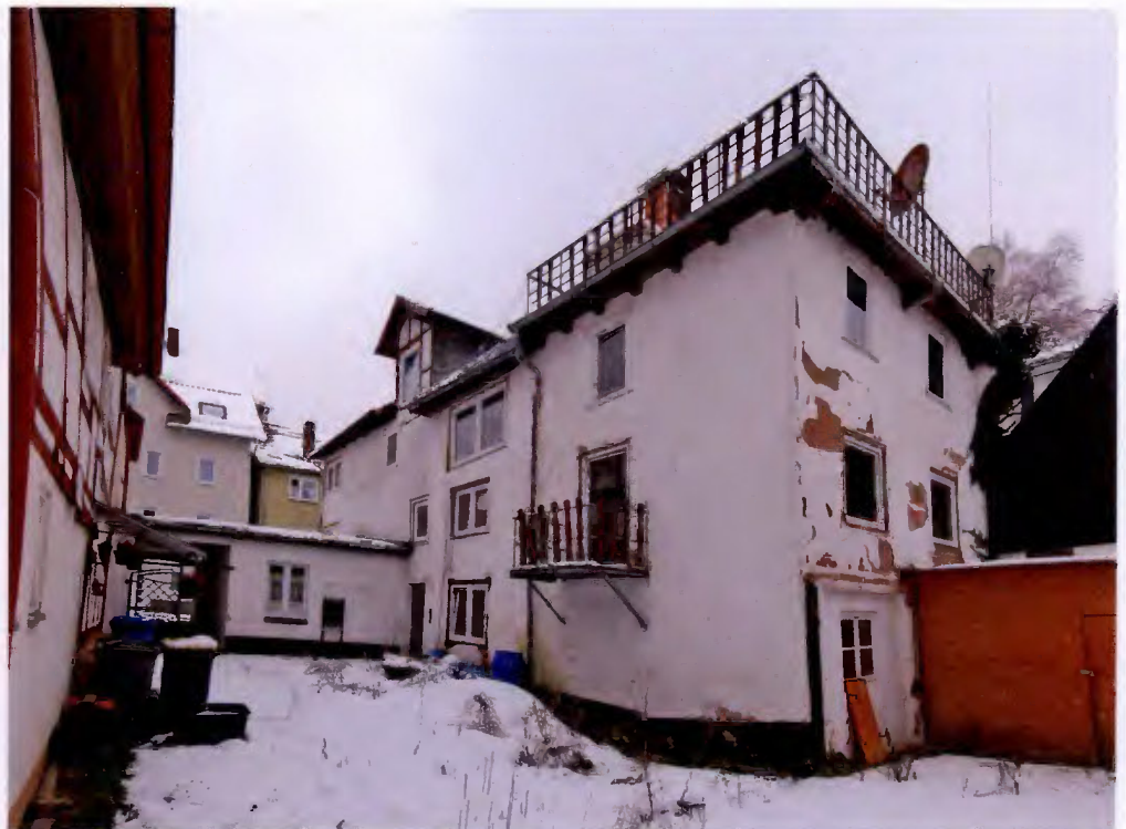
Ansicht des Mehrfamilienhauses vom Innenhof (Nord-Osten)
