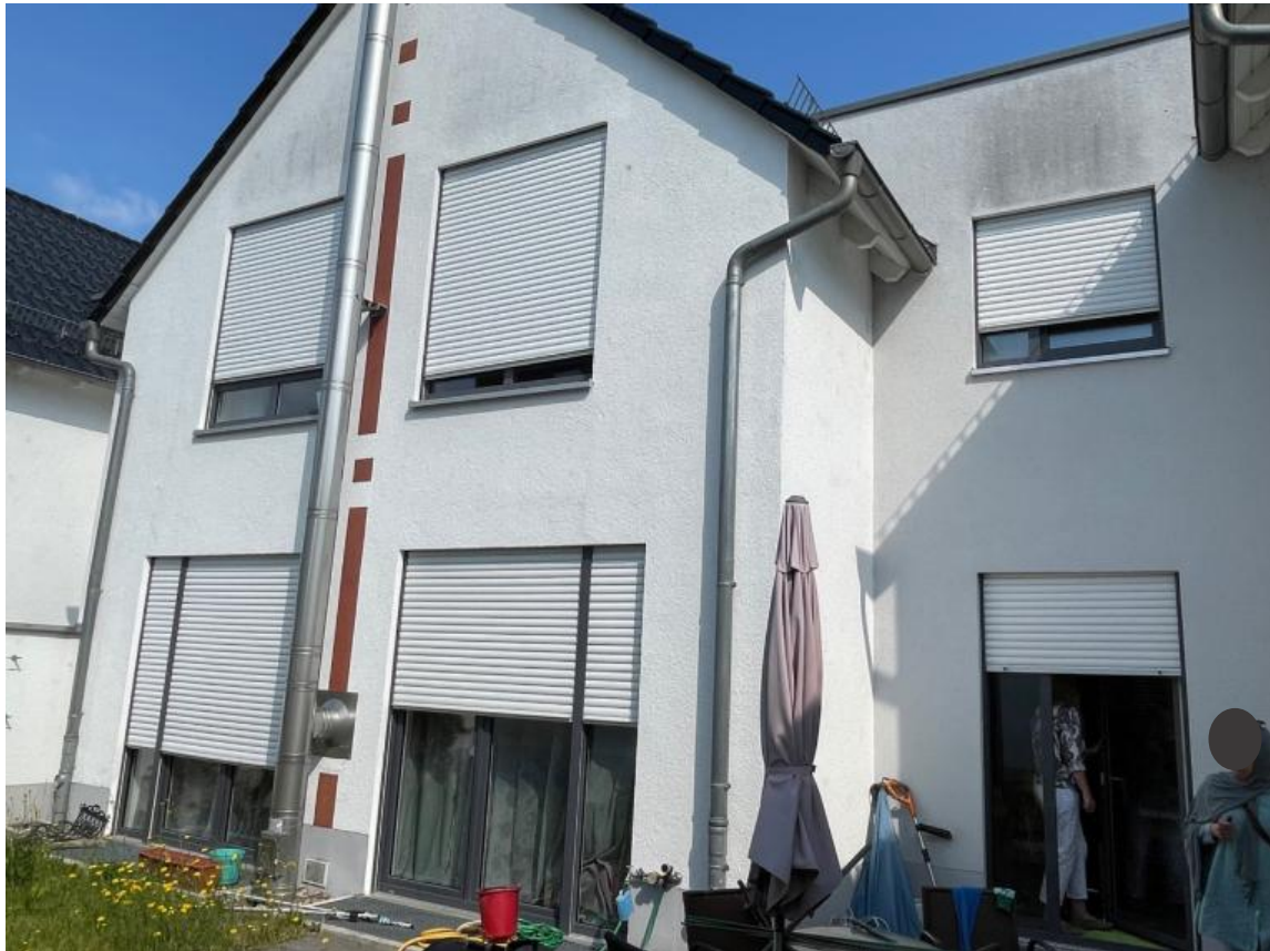
Foto 2: Ansicht des Gebäudes von Südosten
