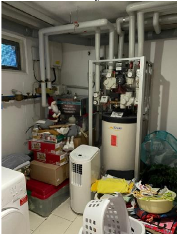
Foto 10: Fernwärmeübergabestation
