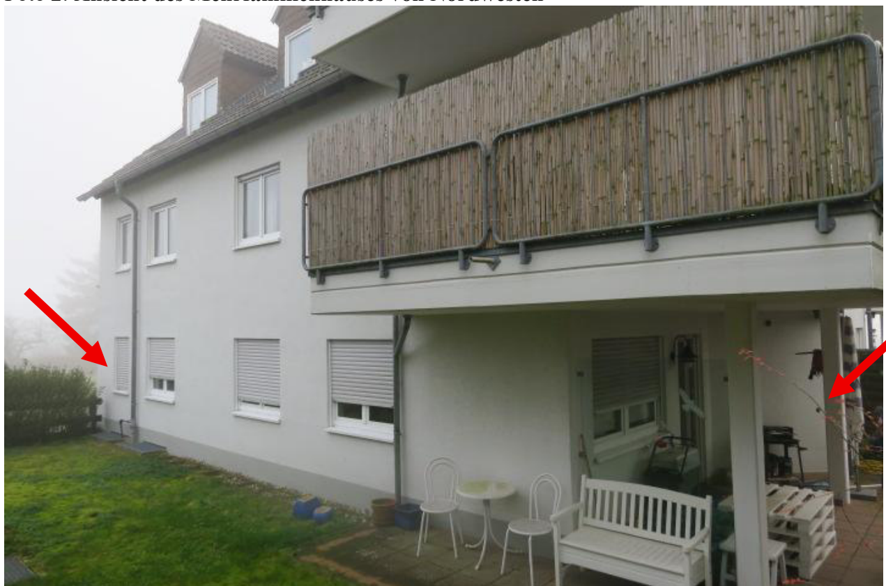
Foto 2: Ansicht des Mehrfamilienhauses von Nordwesten
