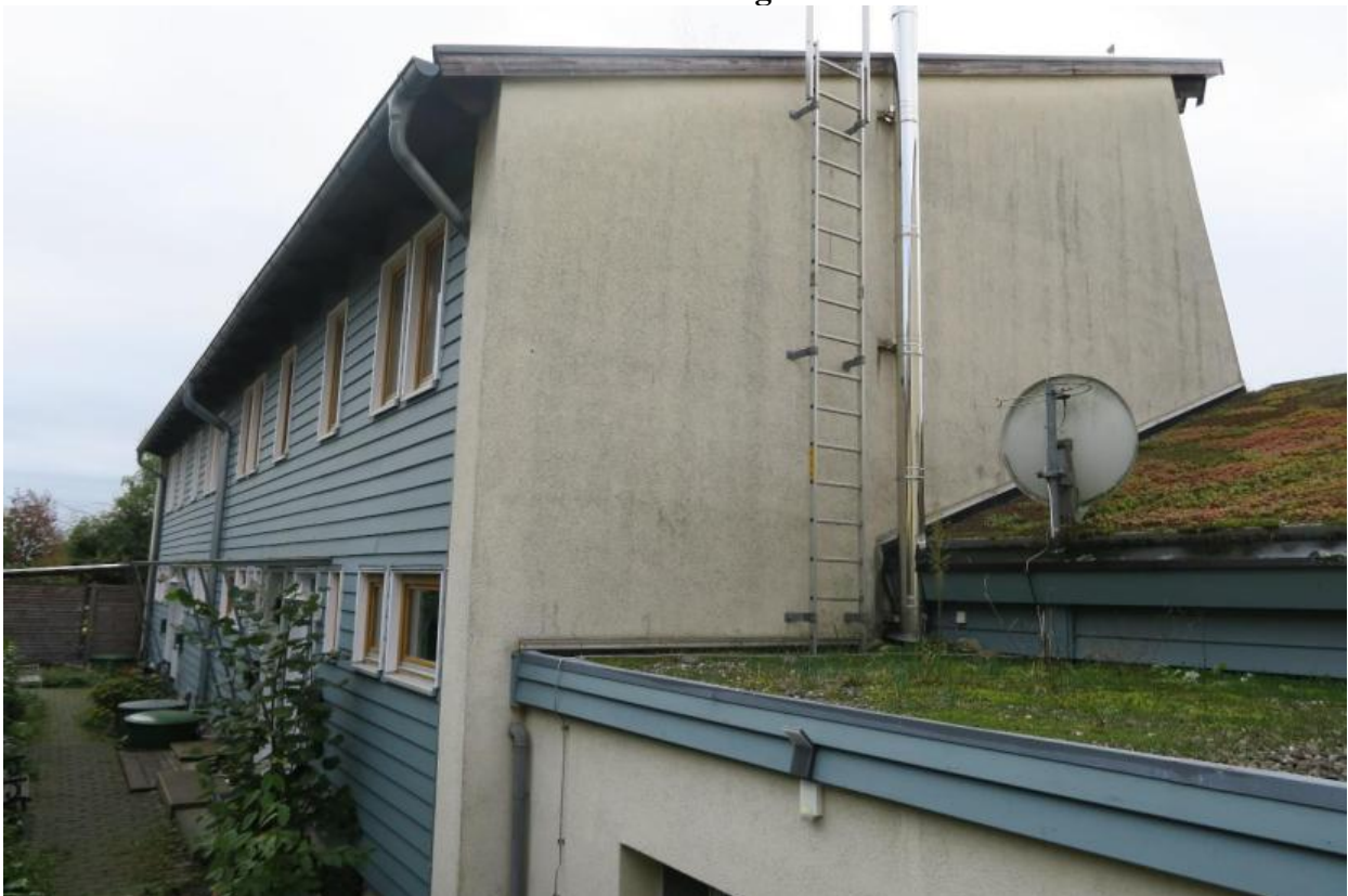
Foto 2: Ansicht des Wohnhauses von dem Wohnweg von Nordwesten
