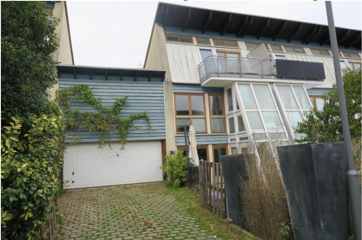
Foto1: Ansicht des Wohnhauses und der Garage von dem Dr.-Karl-Larsen-Weg
