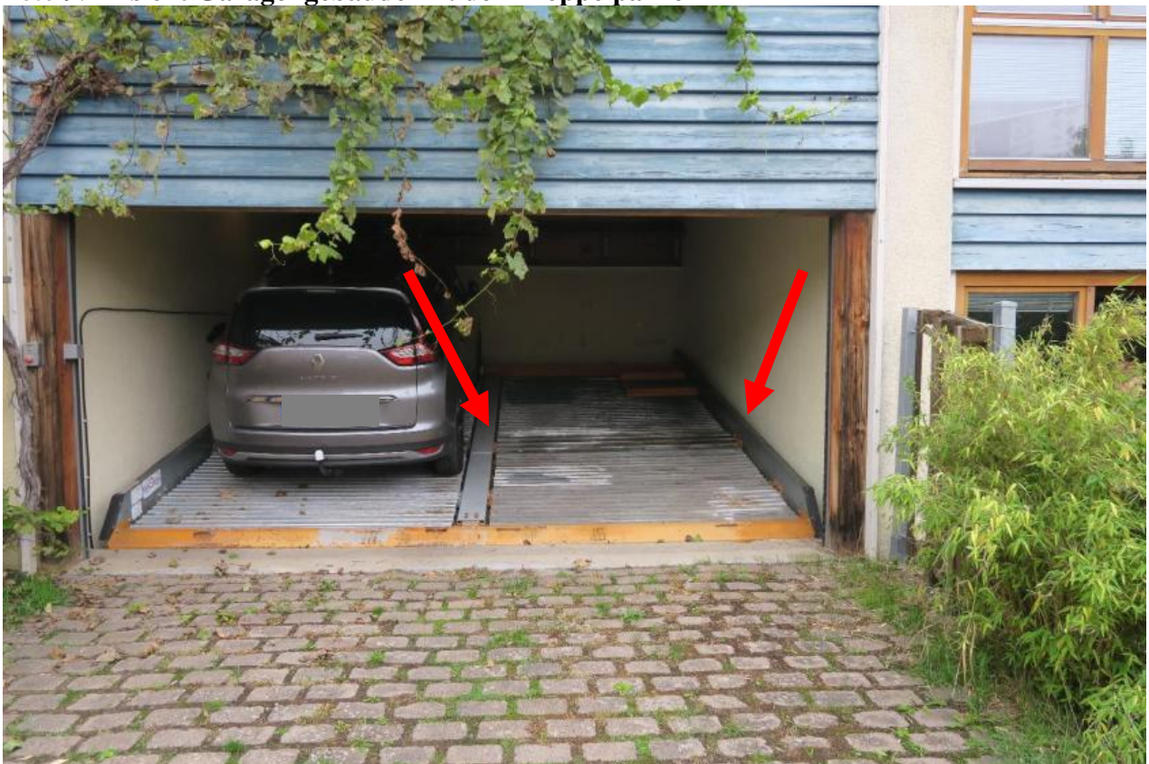
Foto 9: Ansicht Garagengebäude mit dem Doppelparker
