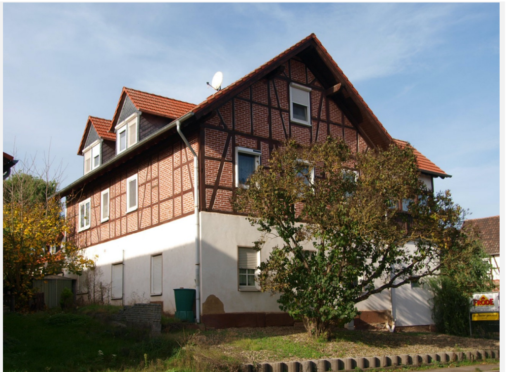
Ansicht des Drei-familienhauses von der Emstaler Straße (Süd-Osten), die zu bewertende Wohnung Nr. 3 befindet sich im Dachgeschoss
