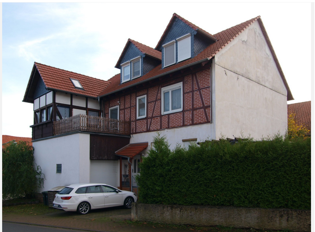
Ansicht des Drei-familienhauses von der Damenallee (Nord-Westen), die zu bewertende Wohnung Nr. 3 befindet sich im Dachgeschoss
