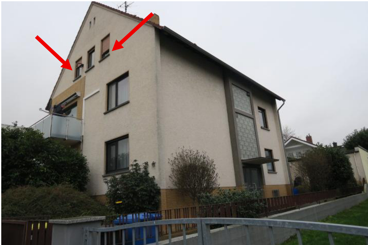
Foto 2: Ansicht des Mehrfamilienhauses von Nordwesten
