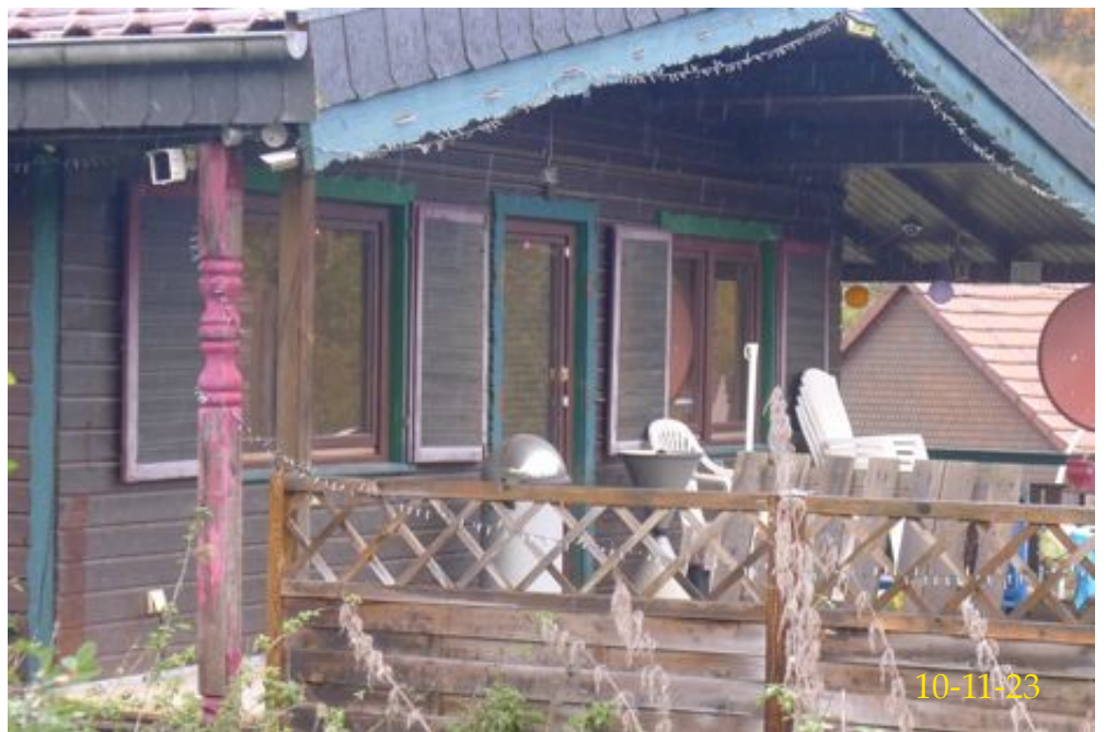
Giebelwand von Süd-Osten
