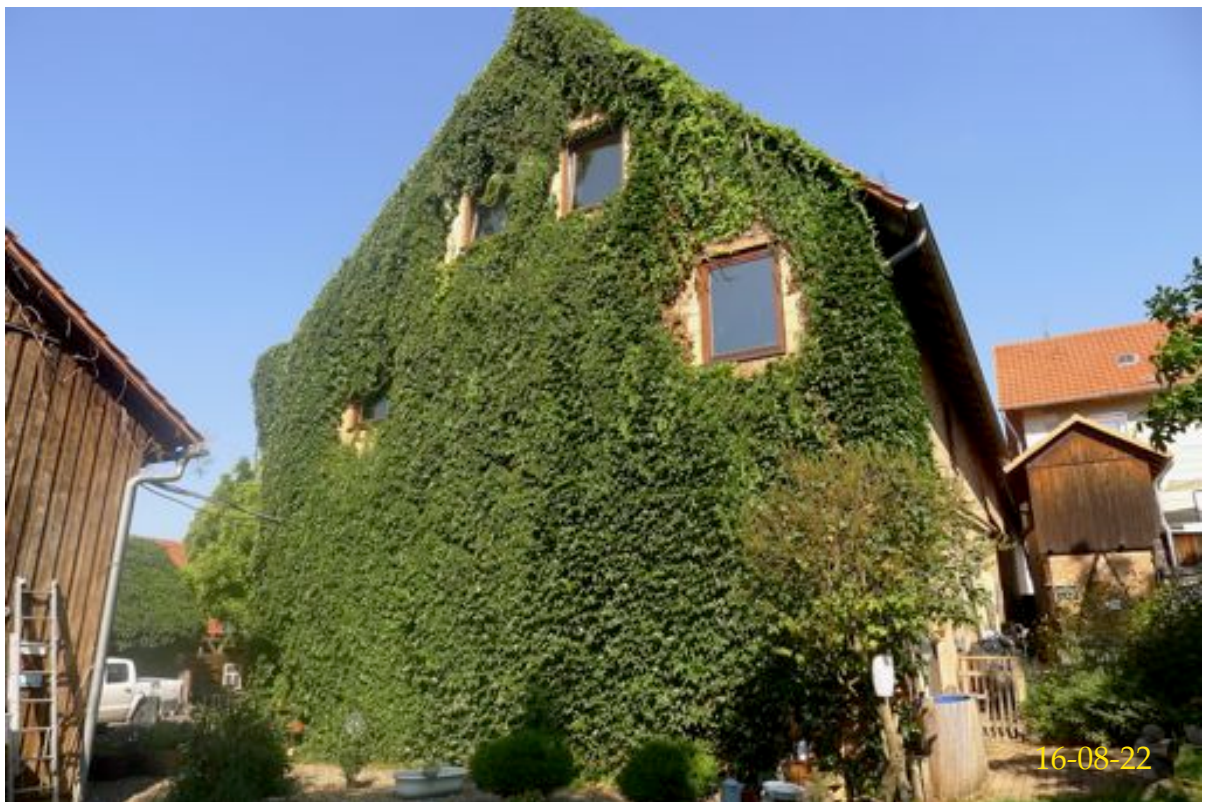
Wirtschaftsgebäude Giebel von Süd-Osten
