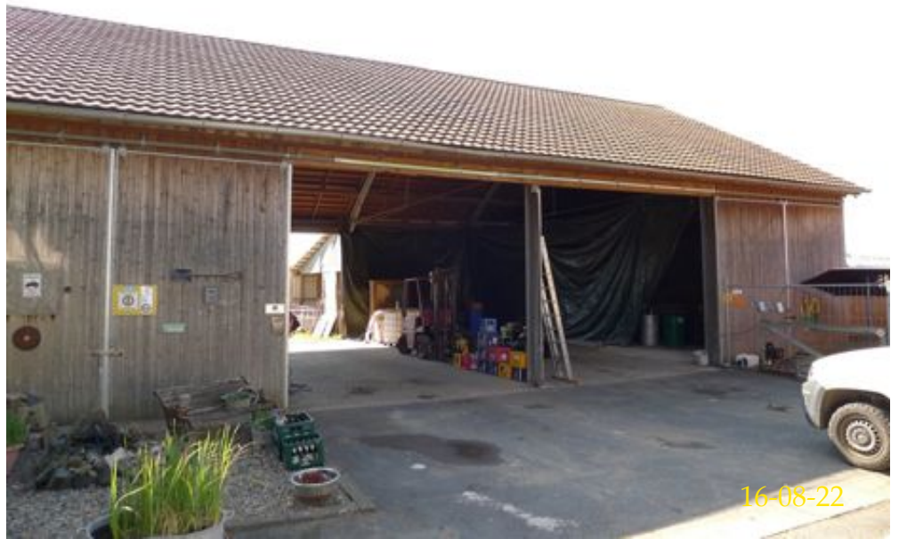
Betriebsgebäude Ansicht von Nord-Westen
