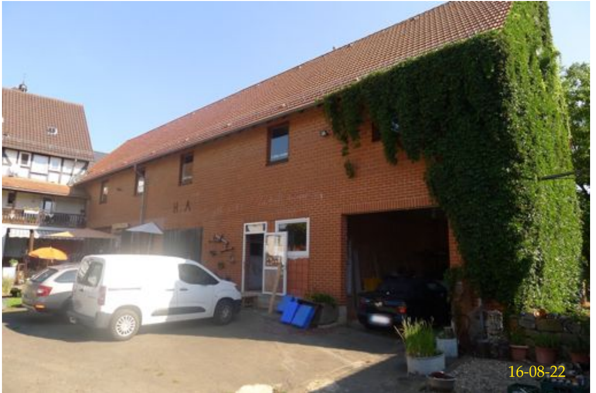
Wirtschaftsgebäude Ansicht von Süd-Westen
