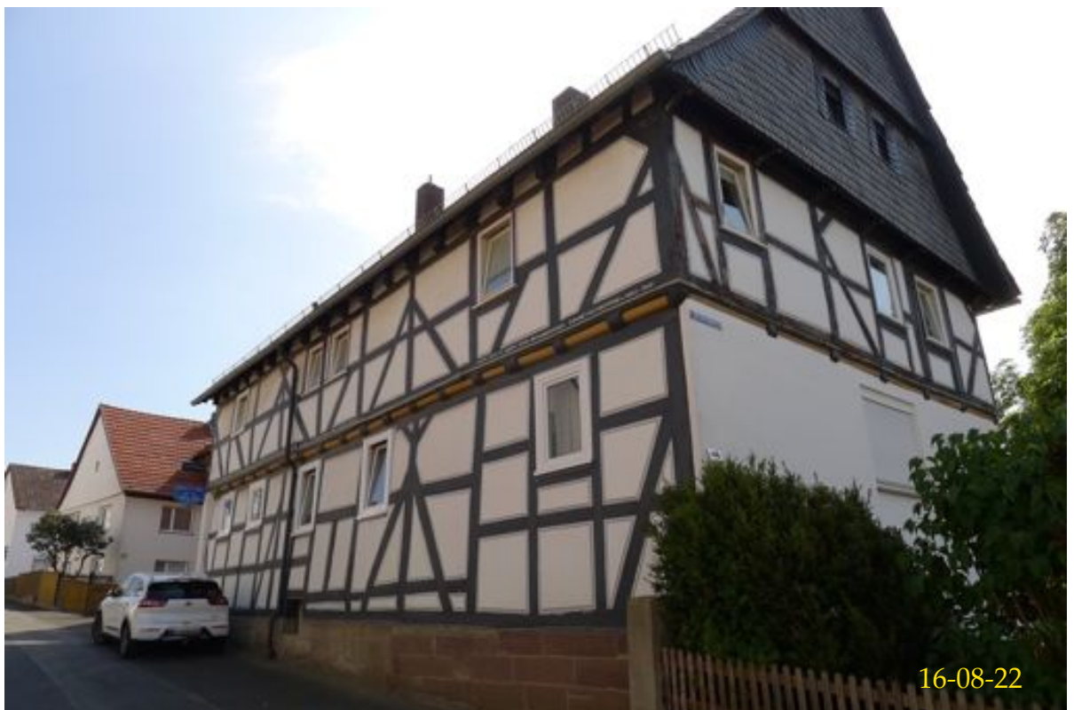
Wohnhaus Straßenansicht von Westen
