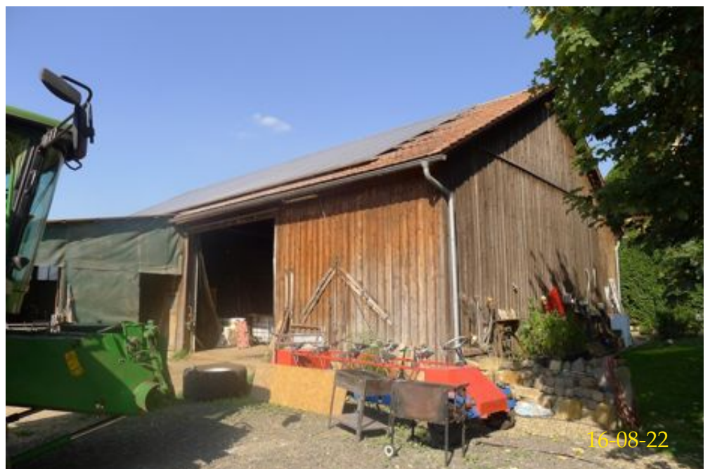
Betriebsgebäude Ansicht von Osten
