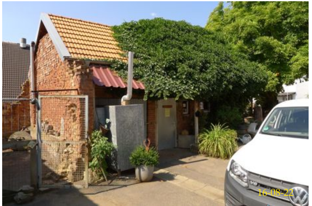
Räucherkammer Ansicht von Süd-Osten
