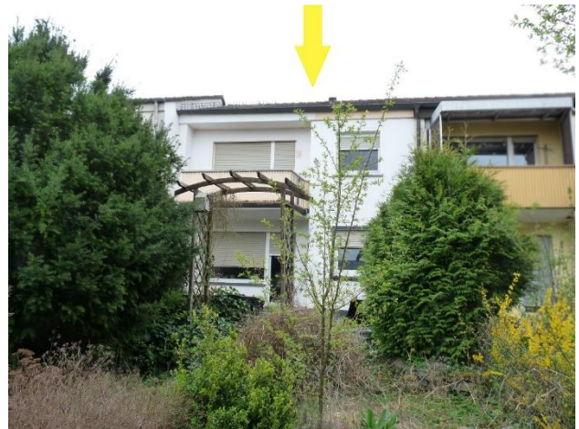
Foto 8 – Blick vom Garten auf die Nordwestfassade, rechts: Nachbarbebauung
