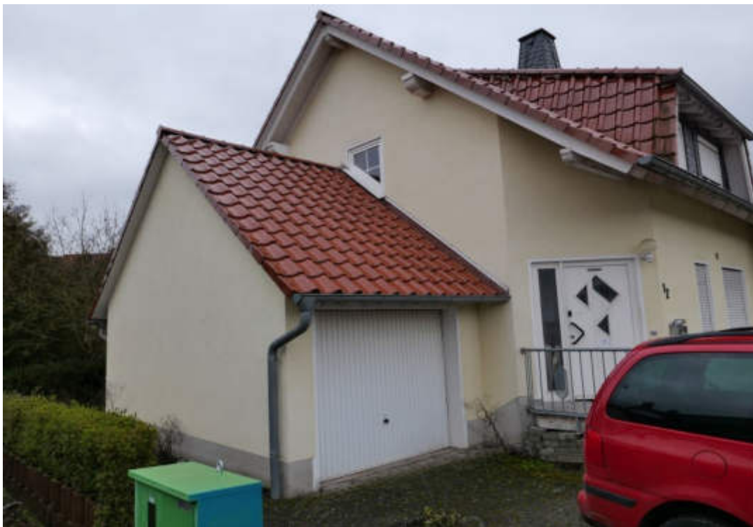
Giebelansicht nord mit Garage
