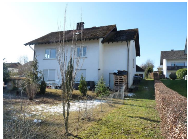
Foto 8 – Blick von der nördlichen Gebäudeecke entlang der Grundstücksgrenze
