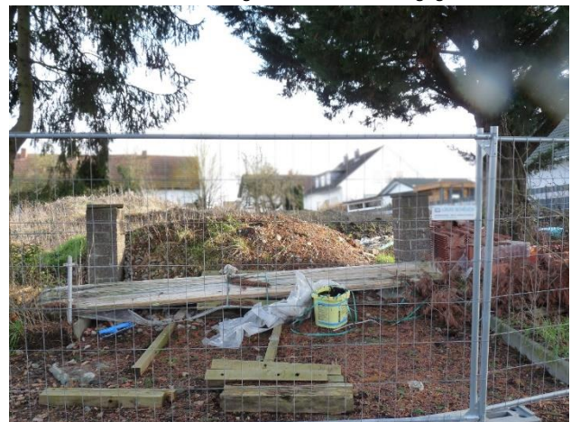
Foto 7 – Blick auf die ehemalige Zufahrt an der Nordseite
