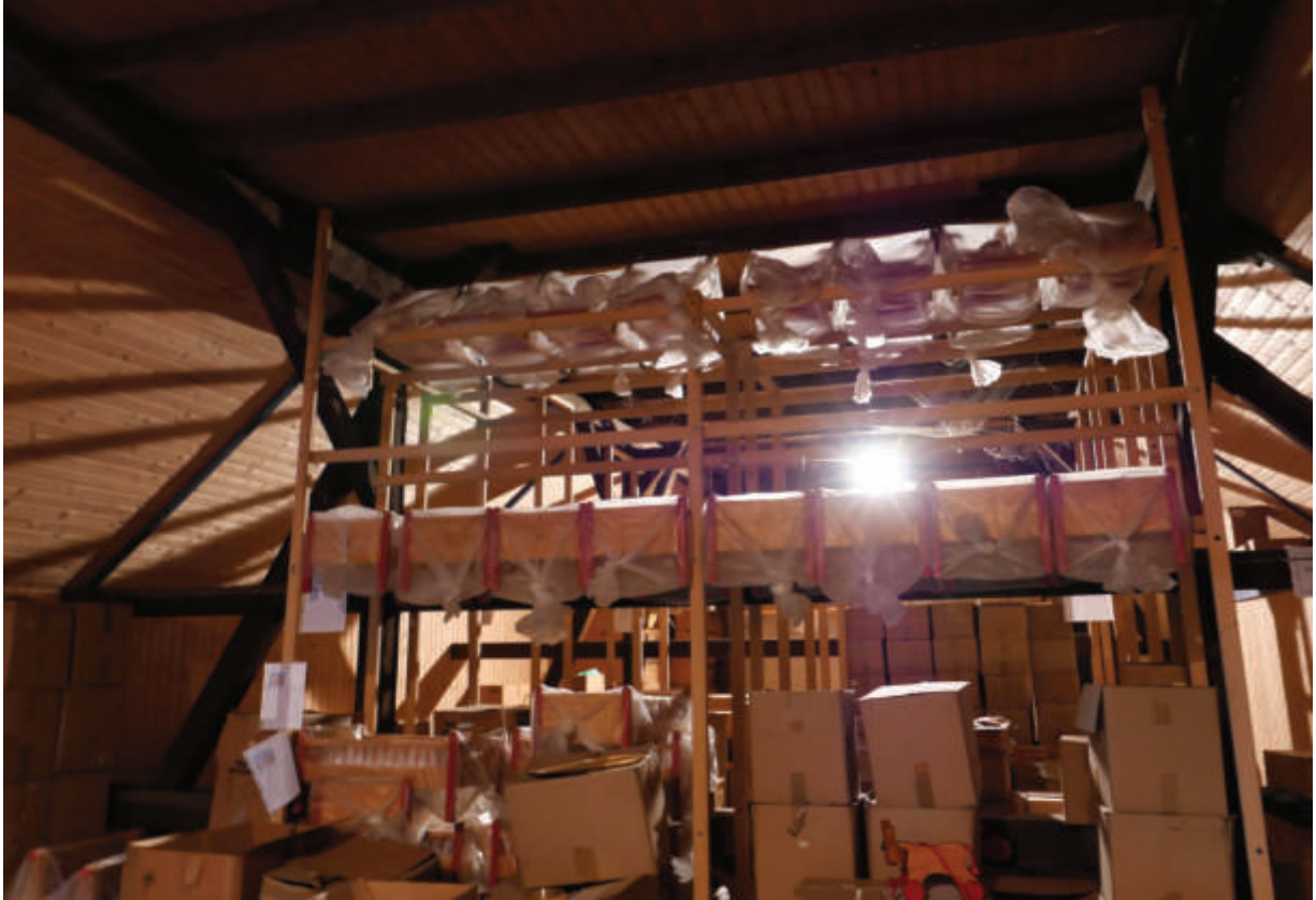
Objektfoto 7 (Innenaufnahme Dachgeschoss Halle, Flurstück 45/3)
