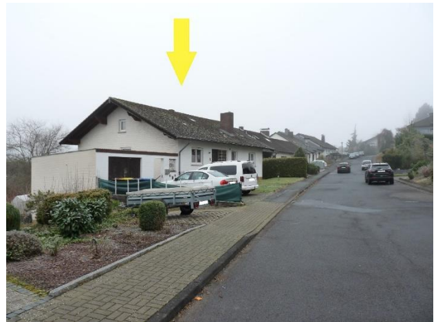
Foto 2 – Blick von der Straße in südwestliche Richtung
