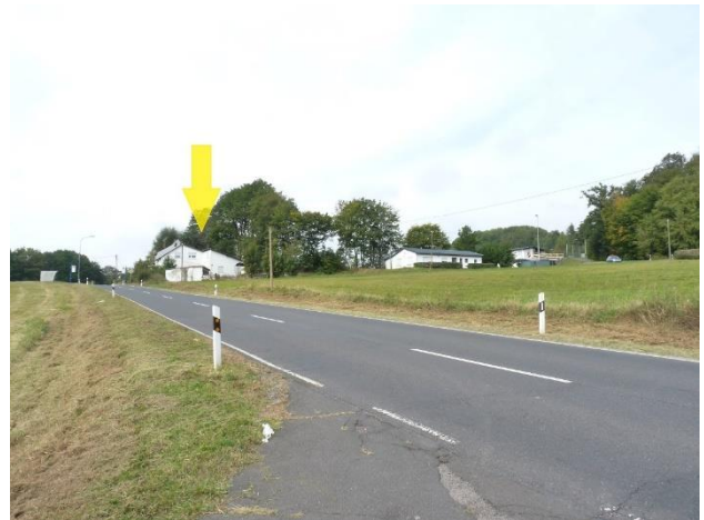
Foto 1 – Lage an der Landstraße
