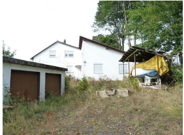
Foto 7 – Blick von der Straße „Sportplatz“ in westliche Richtung auf das Bewertungsobjekt mit Anbau (rechts) und Garagen (Vordergrund links)
