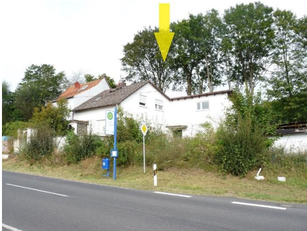
Foto 2 – Blick von der Landstraße in nordwestliche Richtung auf das Bewertungsobjekt
