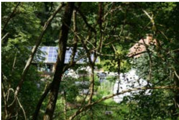
Blick auf Gebäude 4 und Gebäude 2
