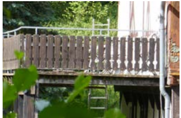
Blick auf Gebäude 1 Details
