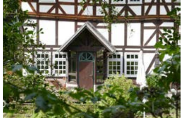
Blick auf Gebäude 1 Details
