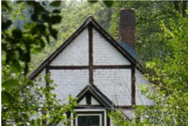
Blick auf Gebäude 3 Details
