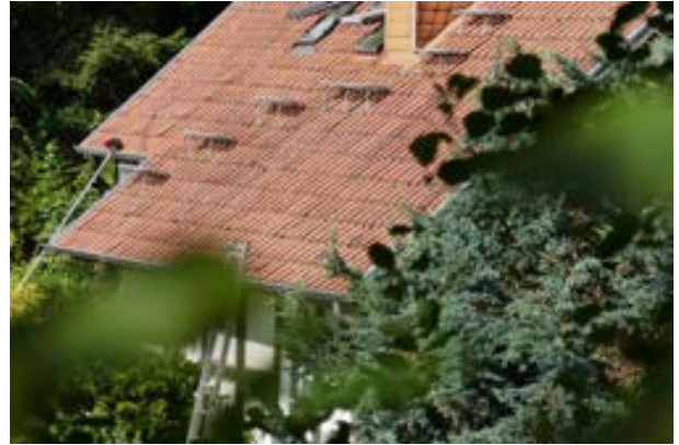
Blick auf Gebäude 2 Detail
