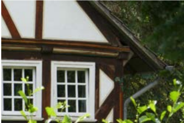
Blick auf Gebäude 1 Details
