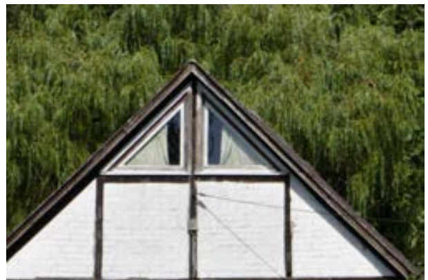
Blick auf Gebäude 3 Detail
