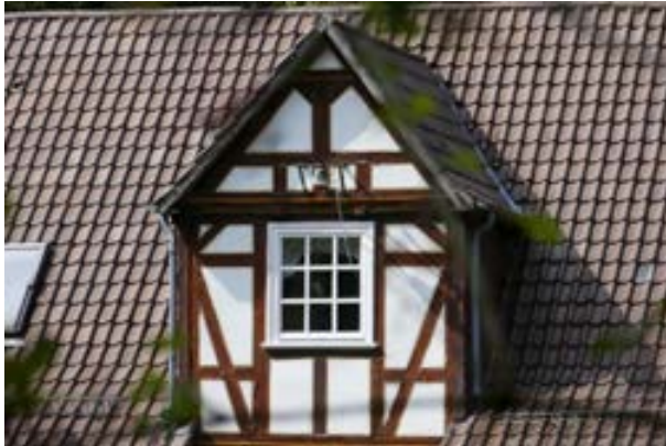
Blick auf Gebäude 1 Details
