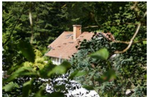
Blick auf Gebäude 2 Detail
