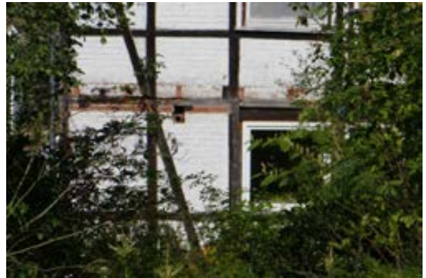
Blick auf Gebäude 3 Detail
