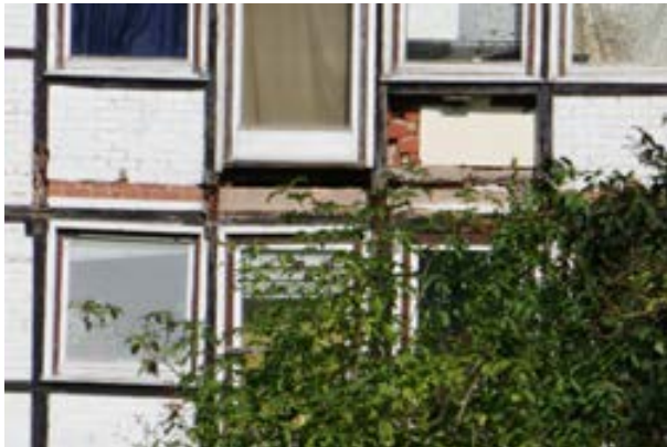
Blick auf Gebäude 3 Detail
