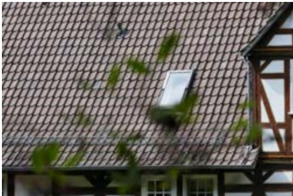
Blick auf Gebäude 1 Details
