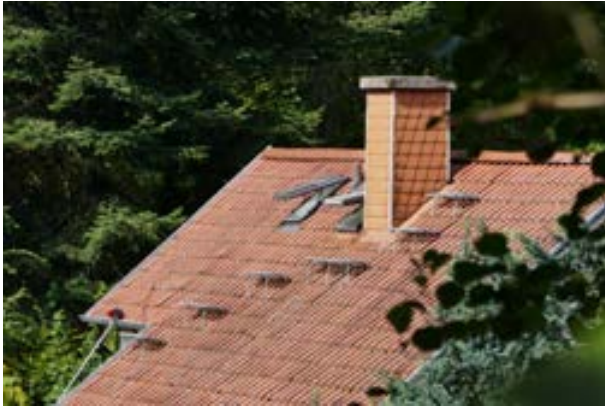
Blick auf Gebäude 2 Detail
