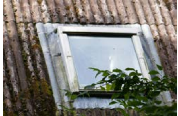
Blick auf Gebäude 3 Detail
