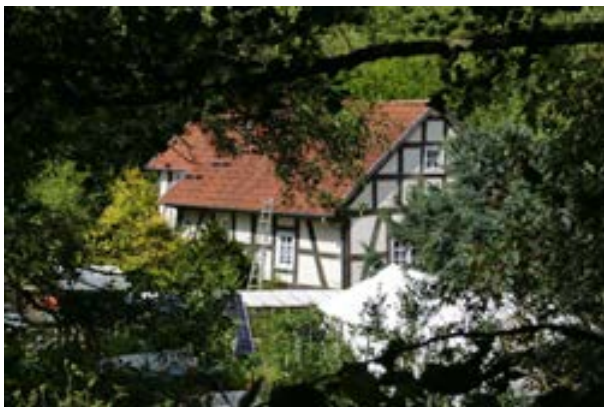
Blick auf Gebäude 2 Detail
