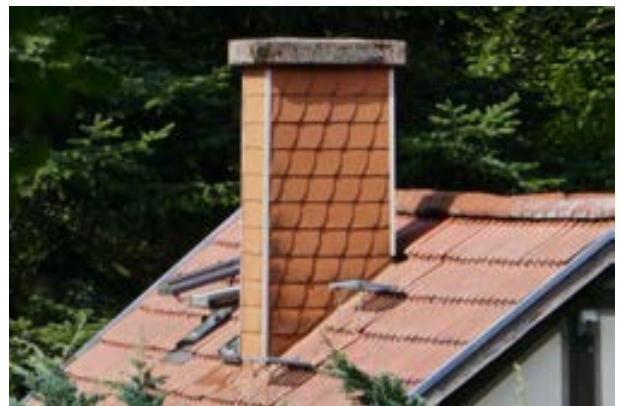
Blick auf Gebäude 2 Detail
