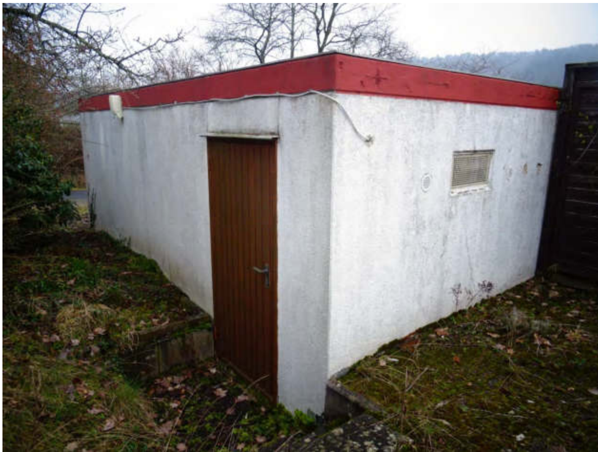
Fertigarage, Stahlbeton, Flachdach, Metall-Schwinger, Metalltür, Metallgitterfenster, Bodenbelag aus Beton
