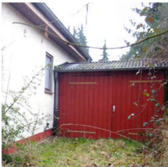
Einfachste Holzkonstruktion, Eindeckung mit Bitumenbahn
