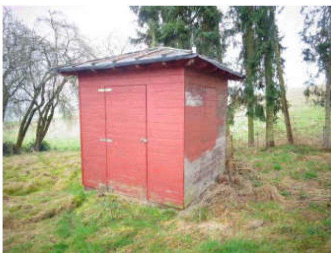
Einfachste Holzkonstruktion, Eindeckung mit Bitumenbahn
