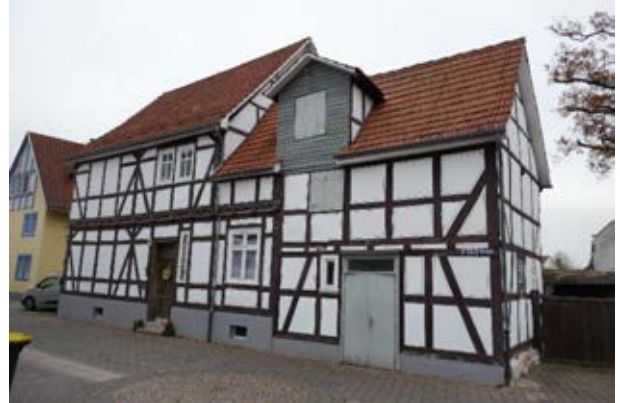
Ansicht West St.-Georg-Straße
