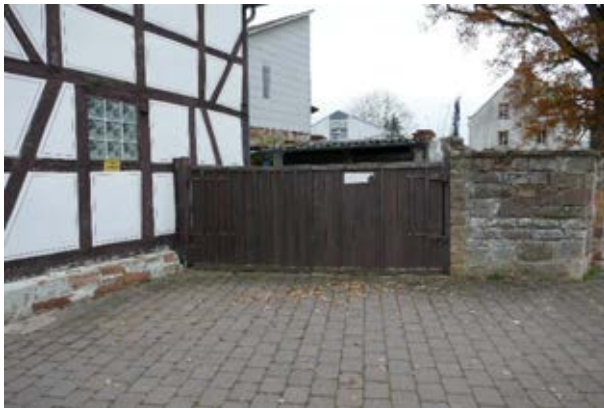
Zugang „Innenhof“ / ehem. Garage
