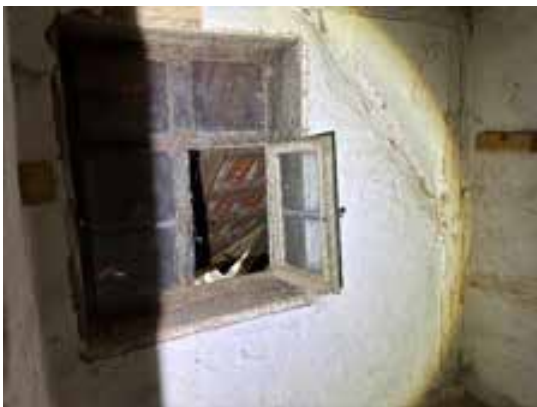
Wohnhaus / Dachgeschoss Innenansicht
