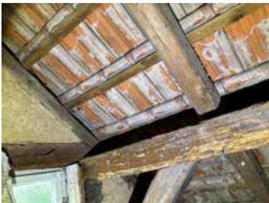
Wohnhaus / Dachgeschoss Innenansicht
