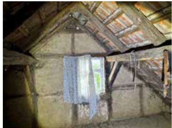
Wohnhaus / Dachgeschoss Innenansicht
