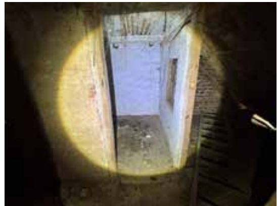
Wohnhaus / Dachgeschoss Innenansicht
