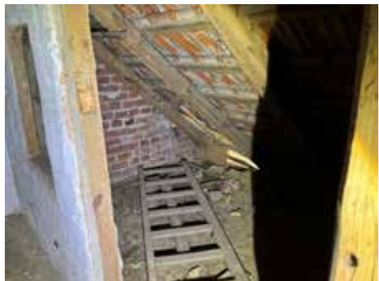
Wohnhaus / Dachgeschoss Innenansicht
