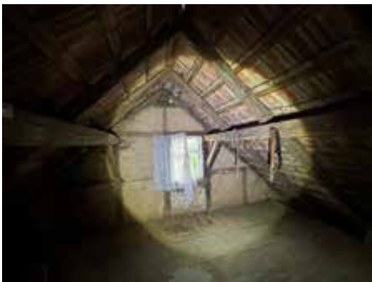
Wohnhaus / Dachgeschoss Innenansicht
