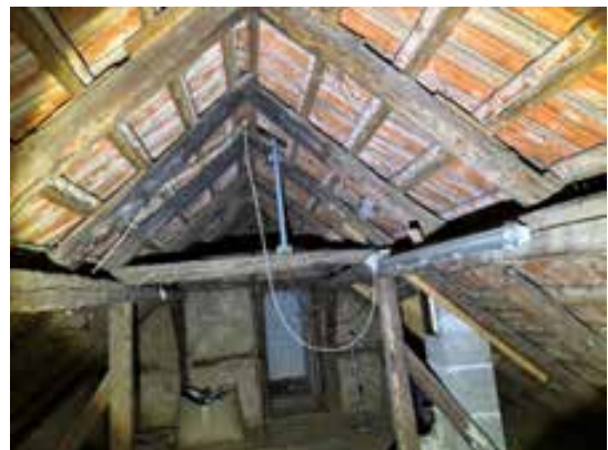
Wohnhaus / Dachgeschoss Innenansicht
