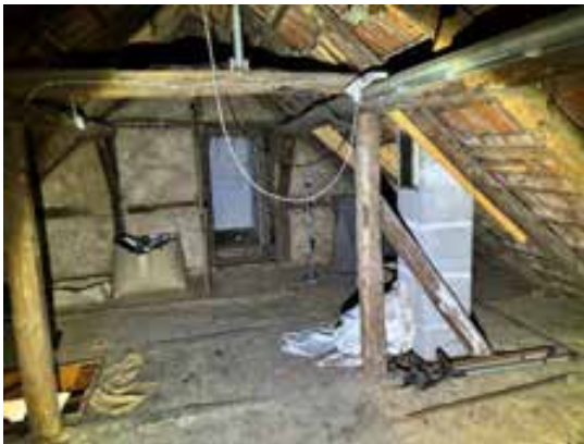
Wohnhaus / Dachgeschoss Innenansicht
