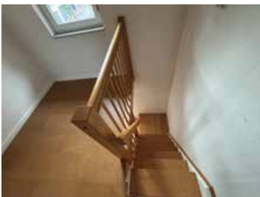
Wohnhaus / Obergeschoss Treppe zu Erdgeschoss
