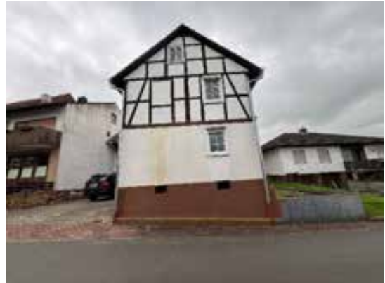
Wohnhaus Ansicht Hohl-gasse Nordostseite
