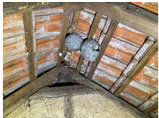
Wohnhaus / Dachgeschoss Innenansicht
