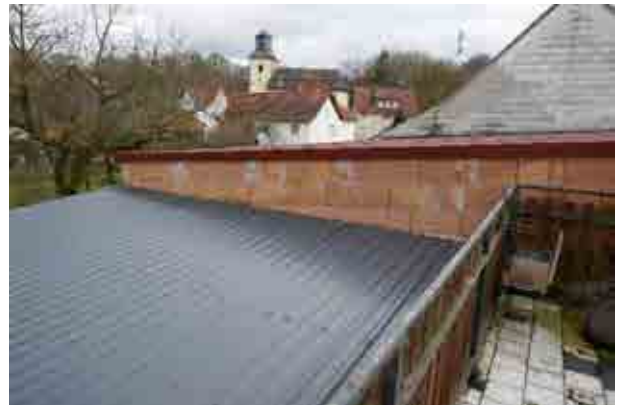
Obergeschoss Dachterrasse / Übergang zu Dach Schuppen
