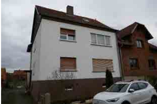
Aussenansicht Schulstrasse Westseite
