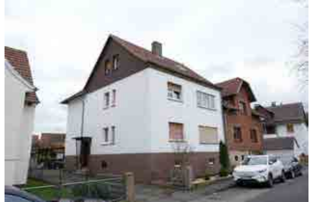
Aussenansicht Nordseite / Westseite
