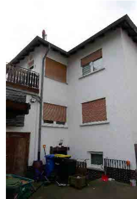
Aussenansicht (Anbau) Südseite / Ostseite
