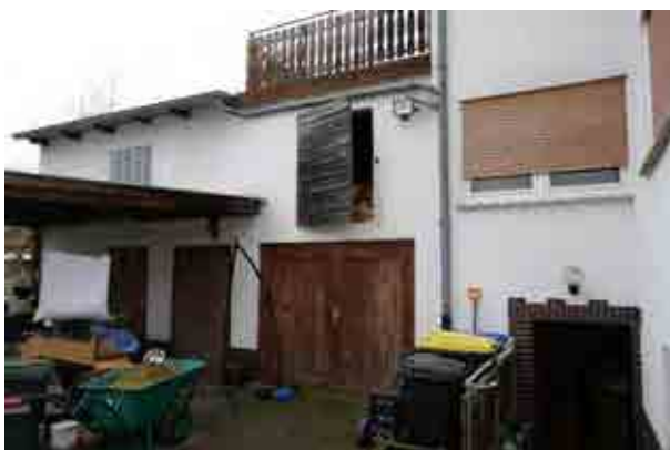
Aussenansicht Hofseite (Schuppen) Südseite
