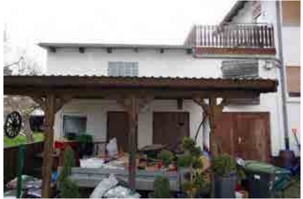
Aussenanlagen Überdachung vor Schuppen
