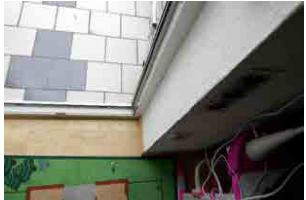
Innenansicht Obergeschoss Zugang Dachterrasse
