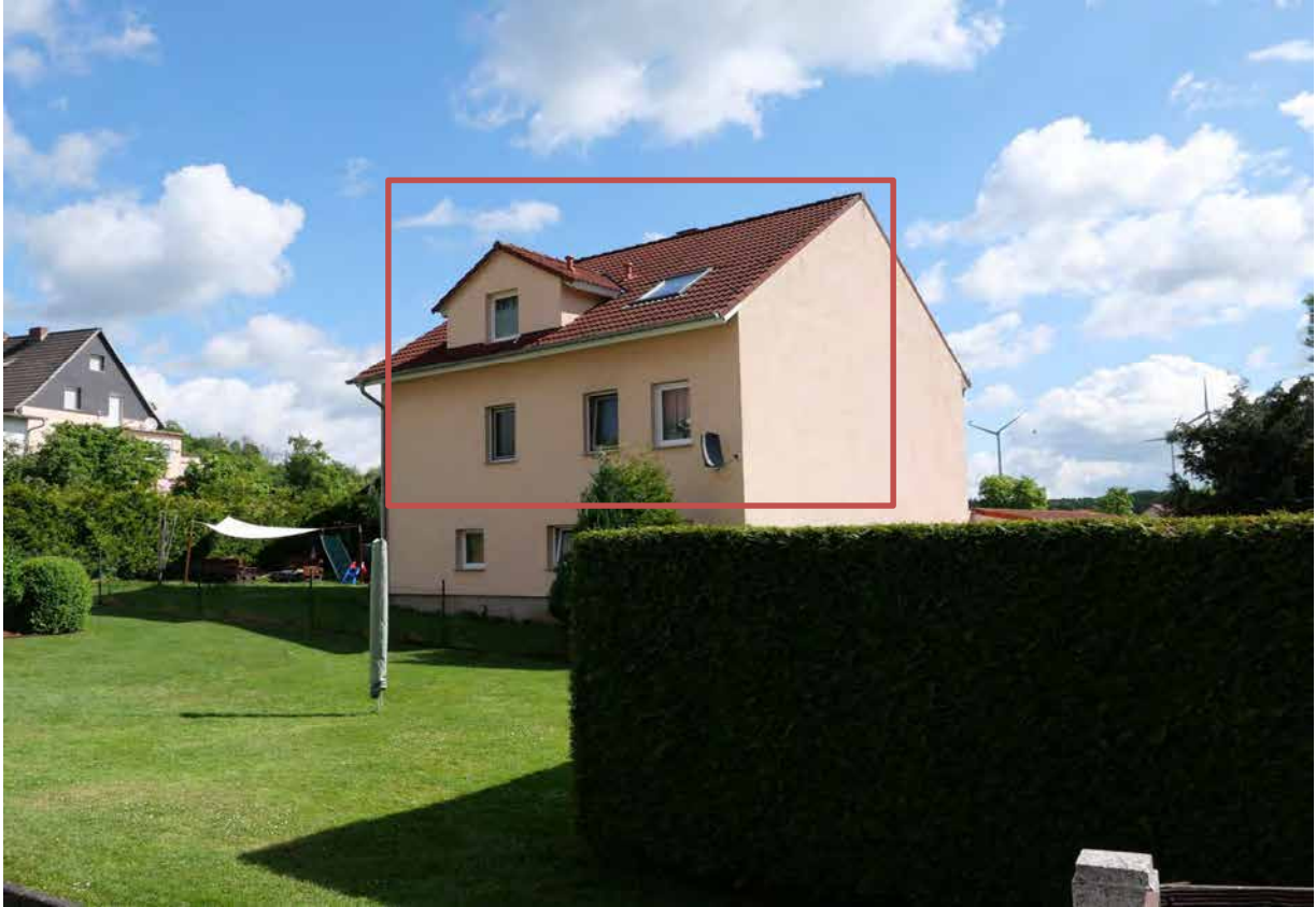
Objektfoto 5 (Traufseite, Wohnräume im OG und DG)
