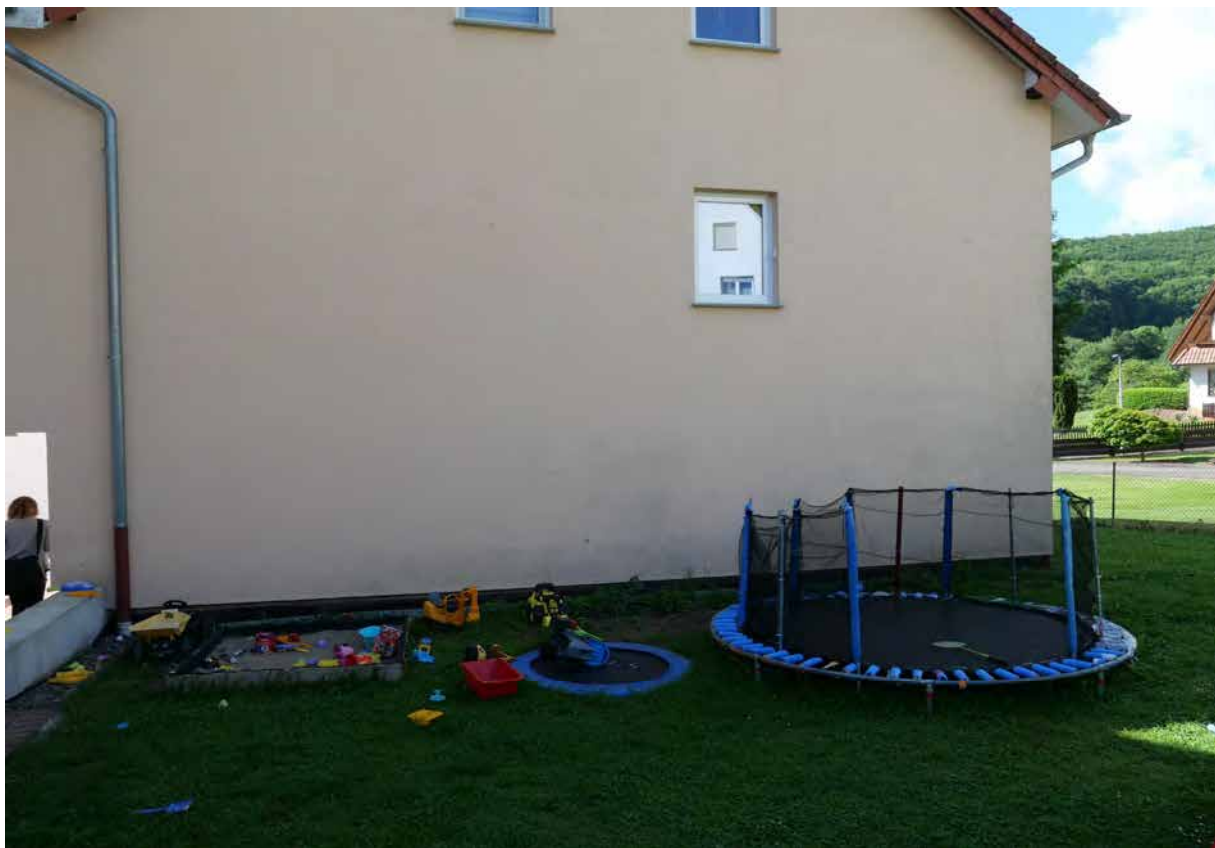
Objektfoto 3 (Giebelseite des Bewertungsobjektes)
