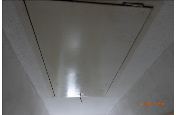
Einschubtreppe zum Dachboden
