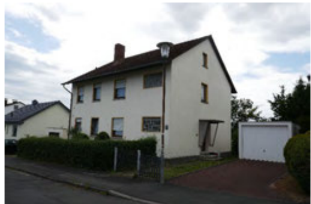
Wohnhaus Ansicht Stettiner Straße Ostseite / Nordseite
