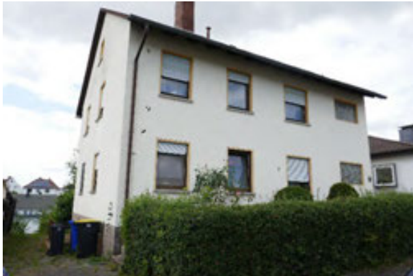
Wohnhaus Ansicht Stettiner Straße Südseite / Ostseite
