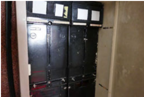
Wohnhaus Treppenhaus (ehem. E-Verteilung)
