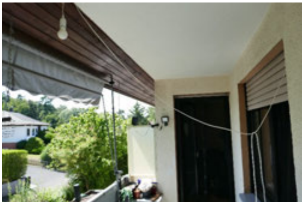
Wohnhaus / Obergeschoss Wohnung 3 / Balkon
