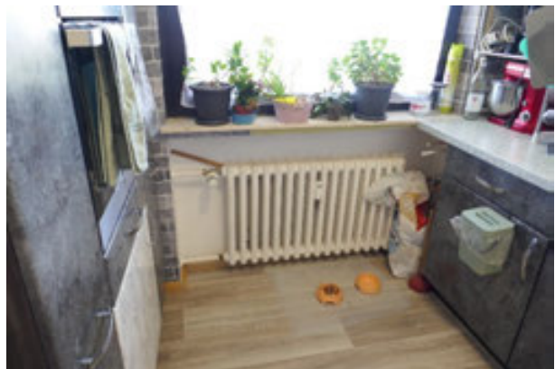
Wohnhaus / Obergeschoss Wohnung 3
