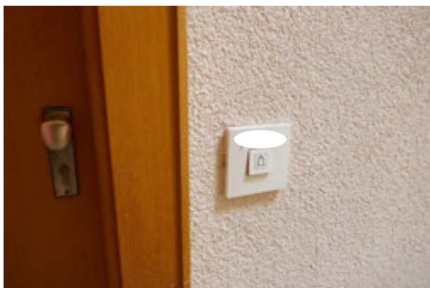
Wohnhaus / Obergeschoss Treppenhaus
