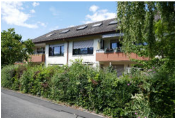
Ansicht Südseite /Kastanienweg
