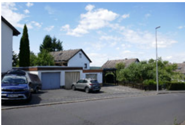
Aussenanlagen Garagen (Nordgrenze)
