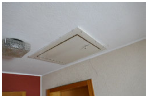
Wohnhaus / Treppenhaus Zugang Spitzboden
