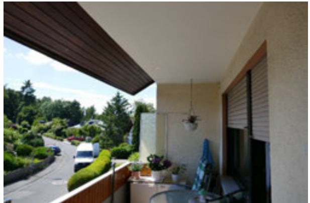
Wohnhaus / Obergeschoss Wohnung 4 / Balkon
