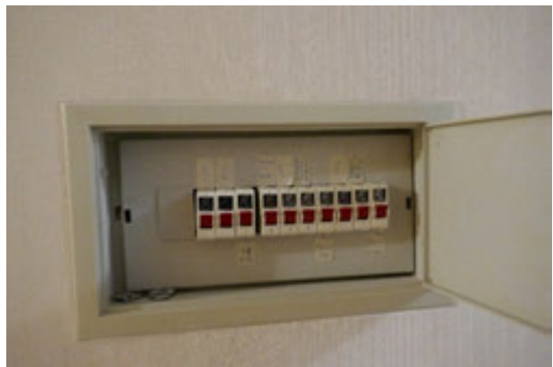
Wohnhaus / Obergeschoss Wohnung 3
