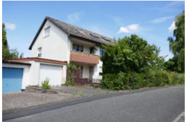
Ansicht Südseite /Kastanienweg
