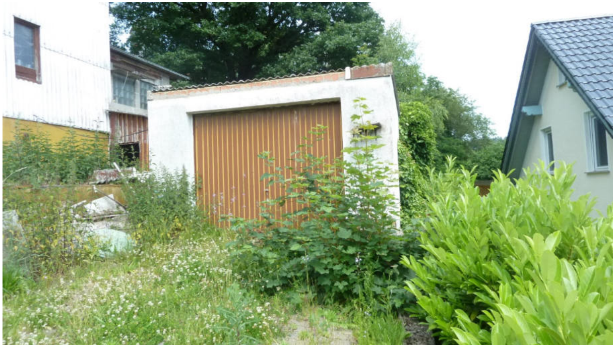
Massive Einzelgarage, Pultdach mit Faserzementwellplatten-Eindeckung, Metallschwingtor
