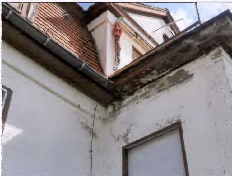
Abb. 12: Schadstelle Loggia / Balkon
