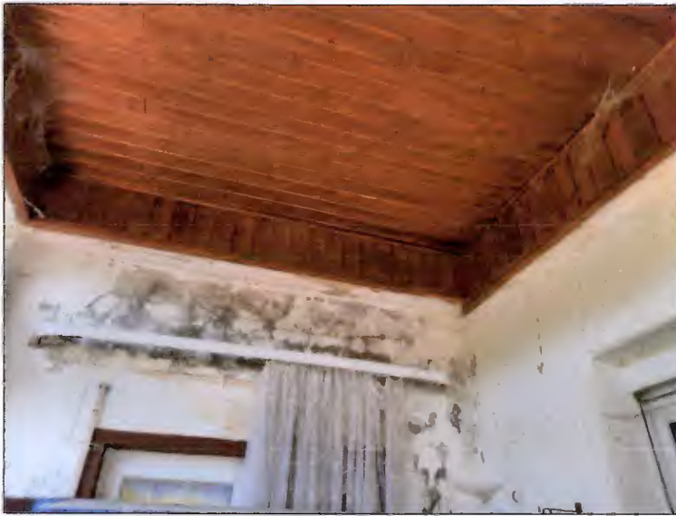
Abb. 16: Feuchteschaden an Loggia
