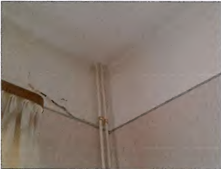
Abb. 17: Feuchteschaden Erdgeschoß innen
