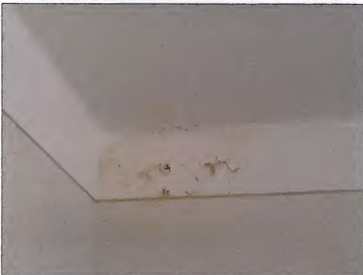
Abb. 18: Feuchteschaden Erdgeschoß innen
