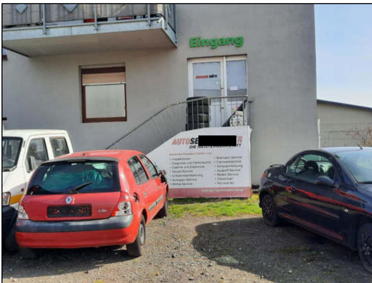
Abb. 8: Außenzugang zum Erdgeschoß
