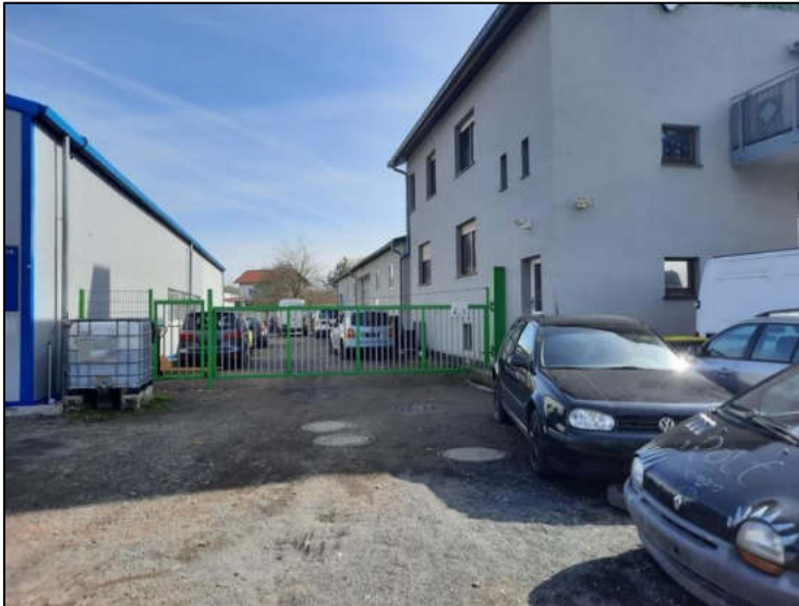
Abb. 4: Vorplatz und Hofeinfahrt
